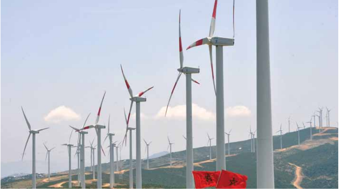
محطة طرفاية لطاقة الرياح تغذي شبكة الكهرباء ب300 ميغاواط. وهي واحدة من مجموعة مزارع رياح تنشأ في المغرب بقدرة إجمالية تصل إلى 2000 ميغاواط
