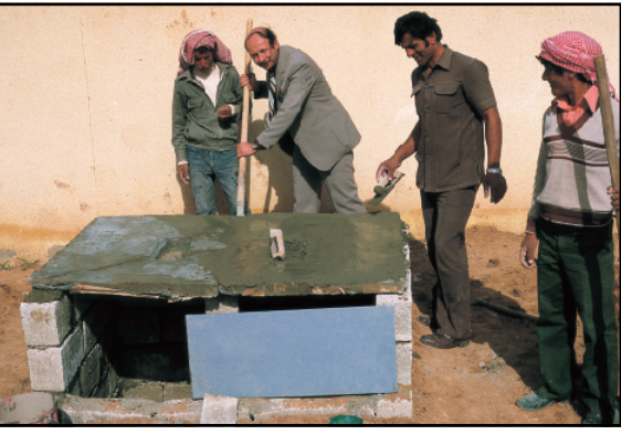
بناء مرحاض صحي لامائي في مدرسة رسمية في الحسكة، سوريا. وهذا المرحاض يستمد الطاقة الشمسية لإنتاج عملية التسميد
