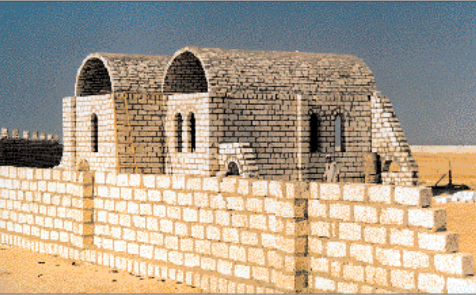
بناء من الحجار الجيرية الطبيعية في محافظة المنيا في مصر. وقد استخدمت هذه الحجار في الجدران والسقوف المقببة
