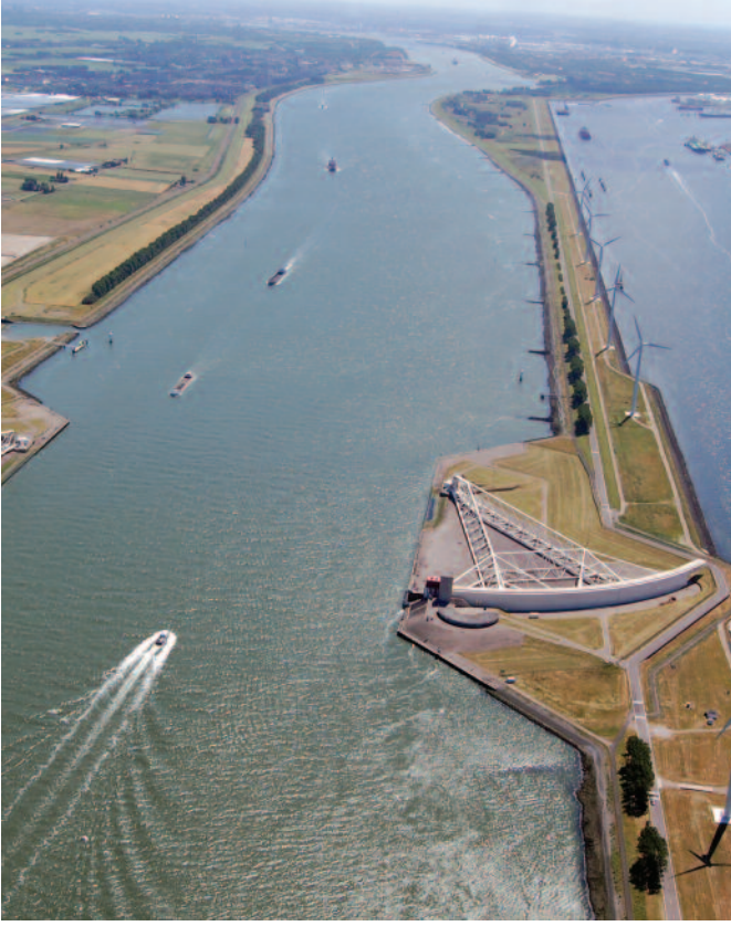
أُنشئ حاجز مايسلانتيكرينغ لحماية ميناء روتردام والبلدات والأراضي الزراعية المجاورة من الفيضان، كما ركبت عليه توربينات لتوليد الطاقة من الرياح
