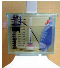
توفر أكياس تقليل حجم المياه حلاً بسيطاً ورخيصاً لتخفيض استهلاك المياه في المراحيض
