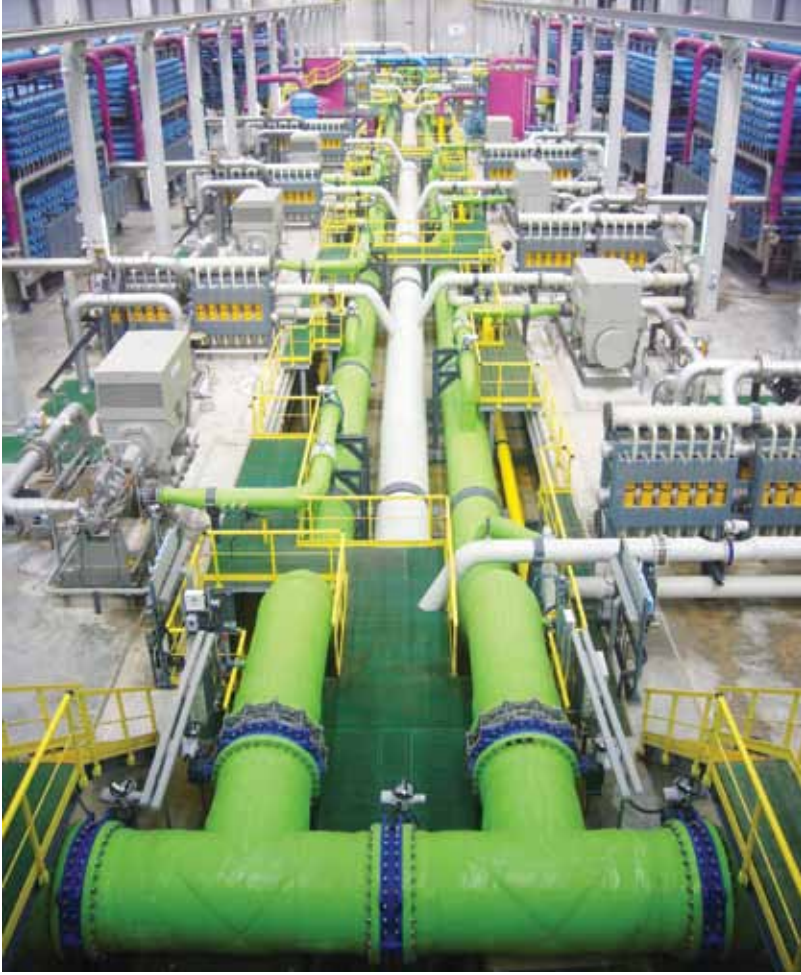
داخل محطة لتحلية مياه البحر بتكنولوجيا التناضح العكسي (Reverse Osmosis)
