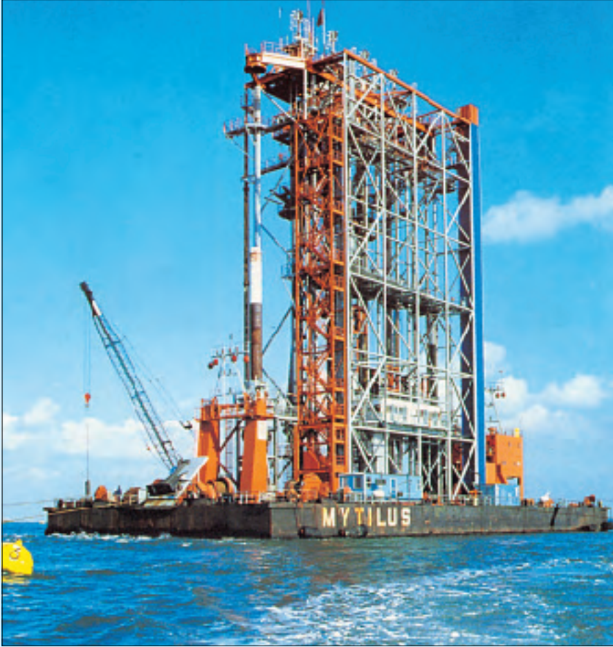
منصة ميتيلوس العملاقة ترص قاع البحر الرملي ليحتمل ثقل سد شيلدت الشرقية
