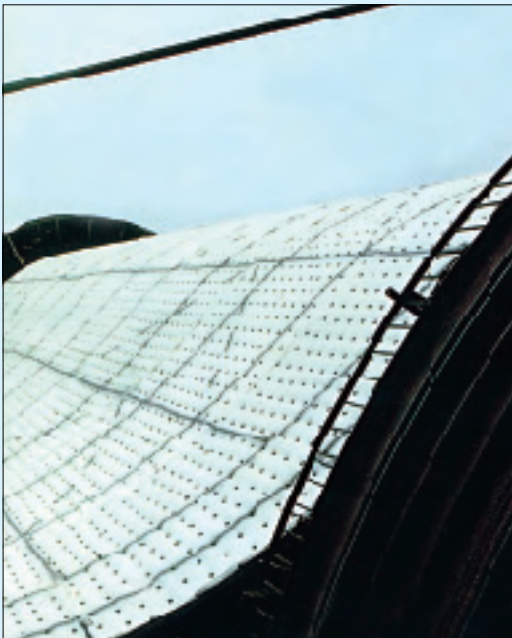
تقنيات ملايين أطنان الاسمنت والصخور والفولاذ لفت حصائر كبيرة على دواليب عملاقة لنقلها الى مواقعها
