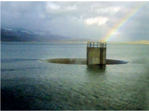
فوق : السد وقد انخفض منسوبه صيفاً تحت : السد ملآن شتاء ويتم تفريغ المياه الفائضة
