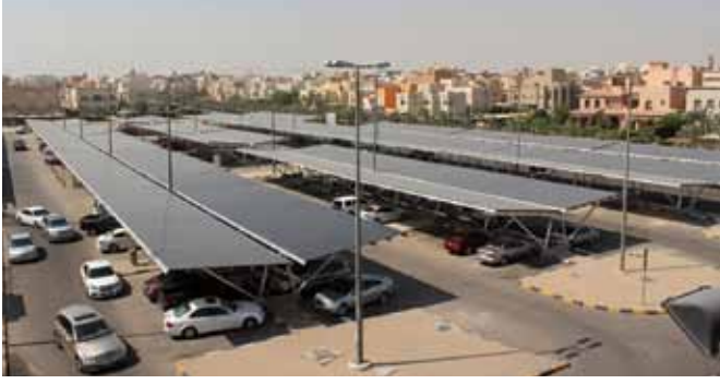
خلايا ضوئية لتوليد الكهرباء بالطاقة الشمسية بقدرة 750 كيلوواط على مظلات موقف جمعية الزهراء التعاونية في الكويت. وقد تبنت مؤسسة الكويت للتقدم العلمي هذا المشروع الذي تم تدشينه في أيار (مايو) 2015
