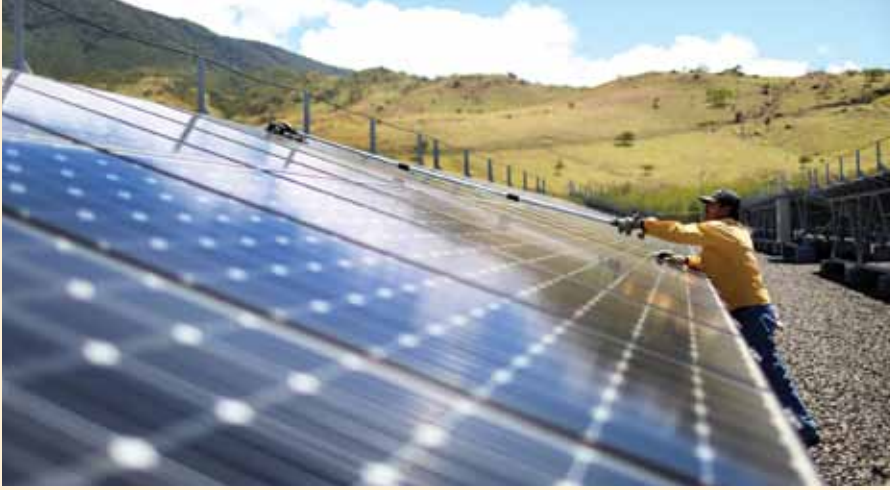
عامل ينظف الألواح الفوتوفولطية في حقل غواناكاست للطاقة الشمسية
