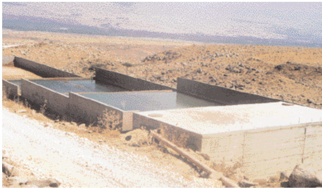
محطة لمعالجة المياه المتذلة في قرية الوزاني في جنوب لبنان
