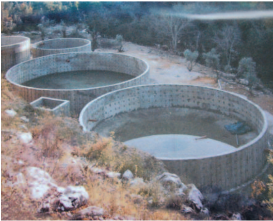
محطة ميكانيكية كهربائية لمعالجة المياه المبتذلة في غريفة تعتمد المعالجة البيولوجية الهوائية بواسطة مفاعل هوائي
