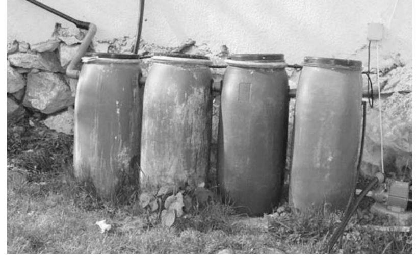
الشكل 18: نظام قياسي لمعالجة المياه الرمادية من نوع الأربعة براميل مركب وشغال في لبنان
