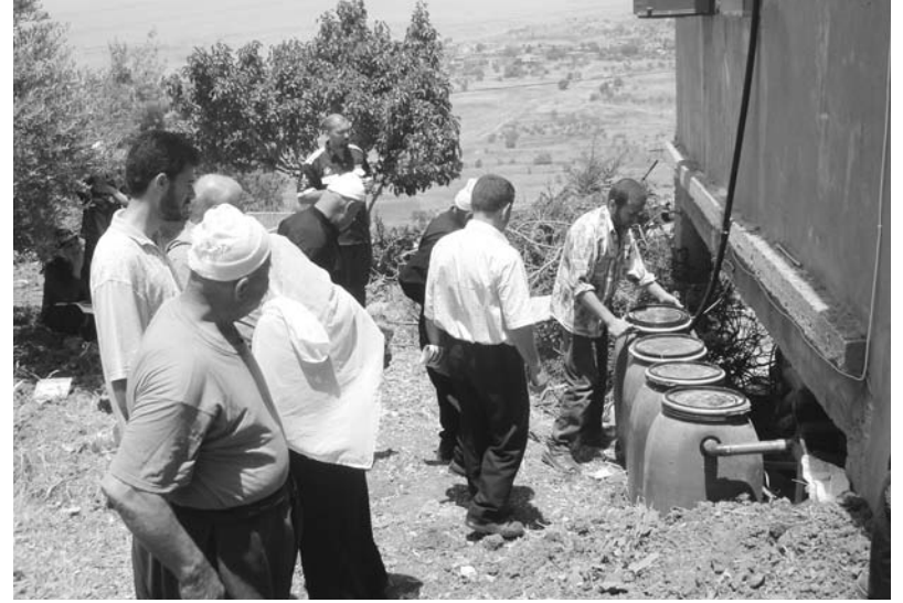
الشكل 9: تركيب أول وحدة لمعالجة المياه الرمادية من نوع الأربعة براميل في تنورة - لبنان
