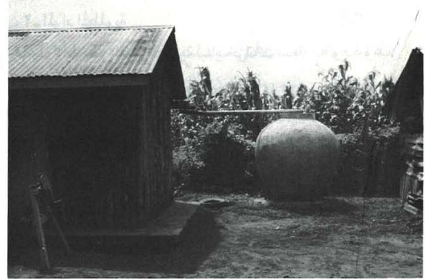
«جرة» من الاسمنت المقوى بالخيزران لحفظ ماء المطر . كاراي ، كينيا .
