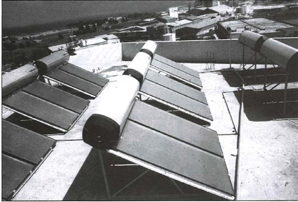
صورة ٦ - نظام كبير من الوحدات الشمسية التي تعمل بطريقة "السيفون الحراري" مركب على سطح مصنع.
